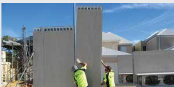
AFS LOGICWALL™ installation
